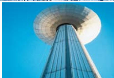
Резервуары для питьевой воды
