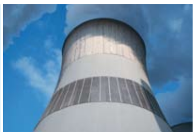
Дымовые трубы и градирни
