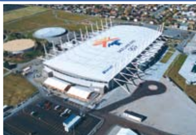
Нанесение логотипа на кровлю
