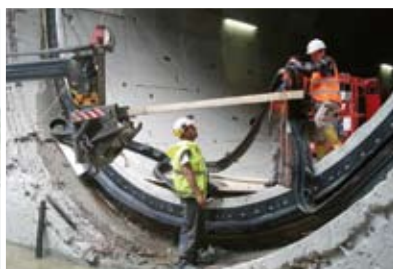
Секционирование при гидроизоляции тоннелей
