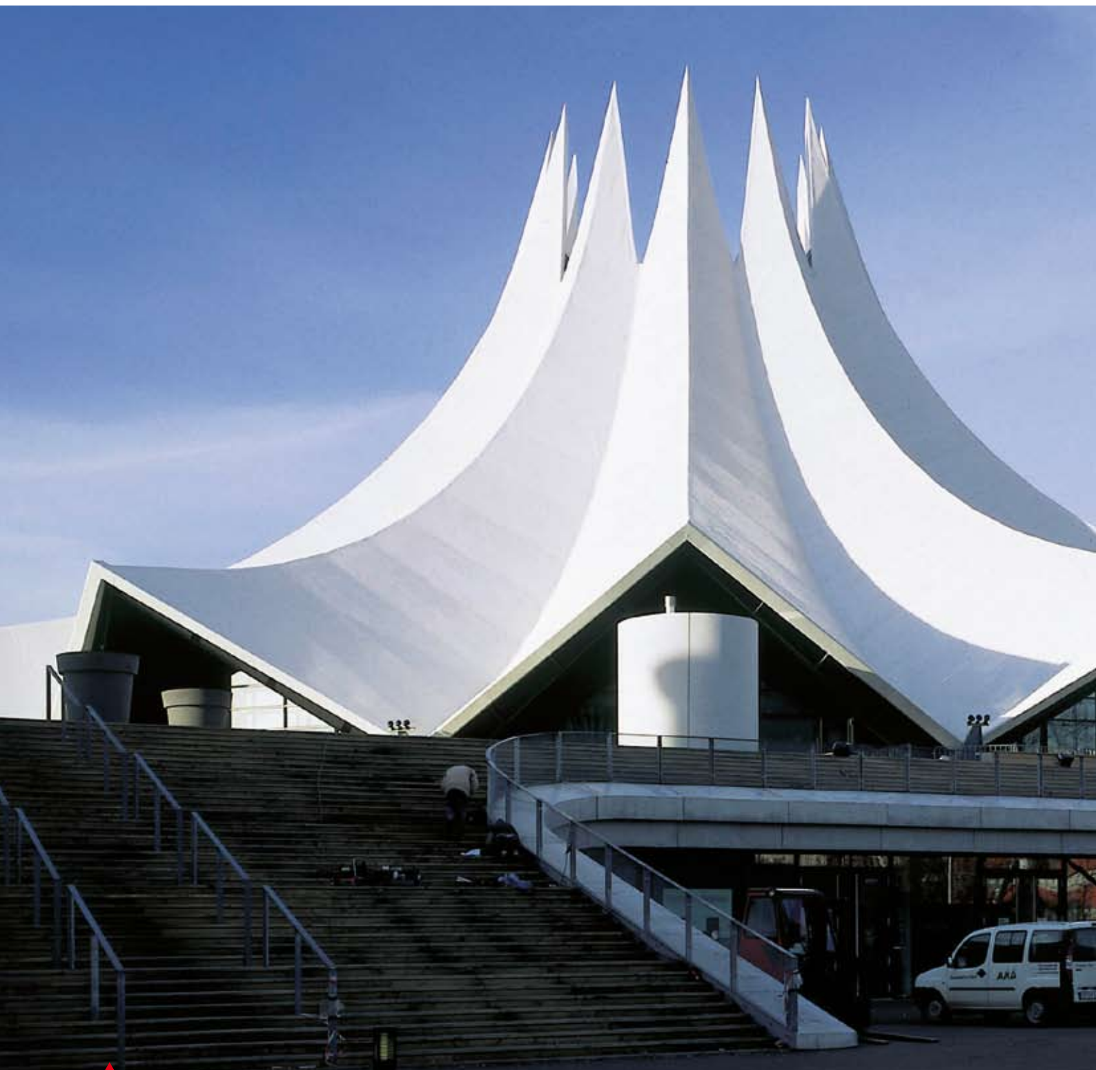
Кровля сложной конфигурации с системой механического крепления мембраны Sarnafil ®, Tempodrom, г. Берлин, Германия
