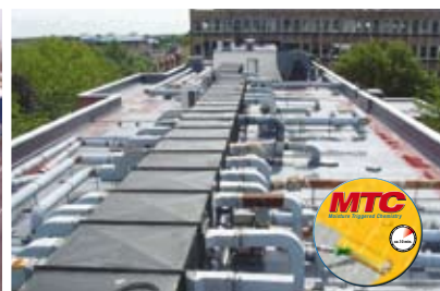
Ремонт кровли с помощью жидких мембран
