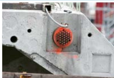
Подливка пучков из арматурных стержней
