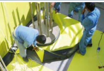
Гидроизоляция с применением мембран
