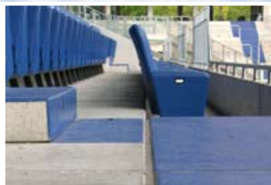
Герметизация деформационных швов напольных покрытий
