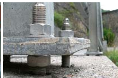
Подливка оборудования и конструкций
