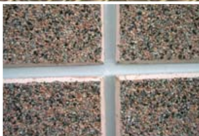
Герметизация швов сборных элементов фасада
