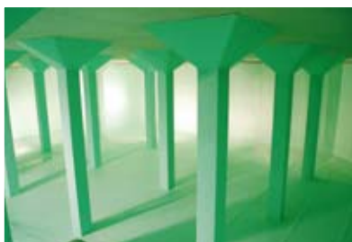
Гидроизоляция резервуаров с питьевой водой
