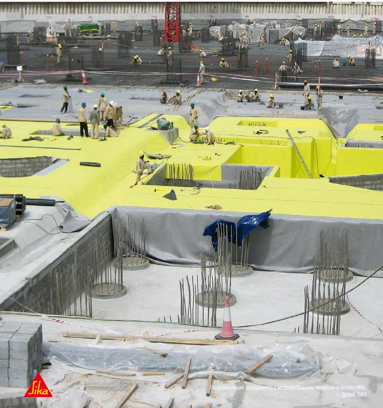
Гидроизоляция с применением мембран
