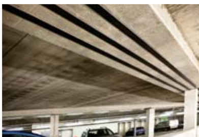
Усиленные конструкции зданий
