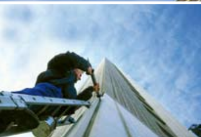
Герметизация фасадных швов
