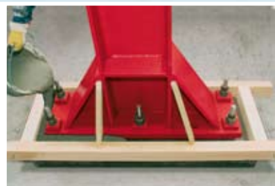
Подливка цементными составами
