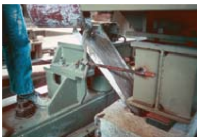
Подливка фундаментов и механизмов
