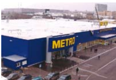
Кровли классические кровли, Москва (Россия)
