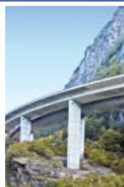
Ремонт, защита и усиление бетона
