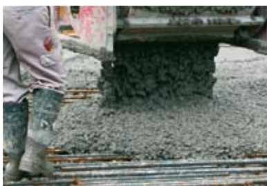
Применение специального бетона
