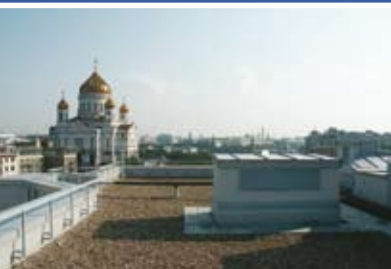
Кровли с балластом из гравия
