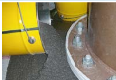
Подливка эпоксидными составами
