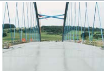
Гидроизоляция пролетных конструкций моста
