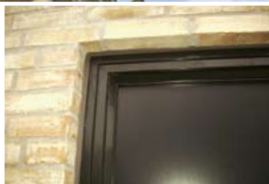
Герметизация фасадных стыковых соединений
