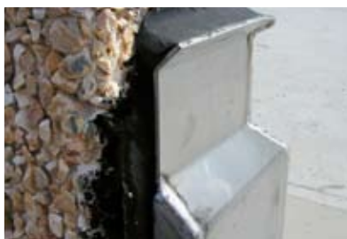
Кровельные стыковые соединения
