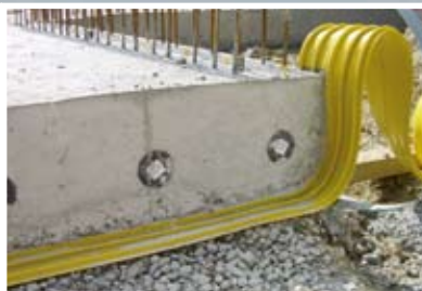
Гидроизоляция с помощью гидрошпонок
