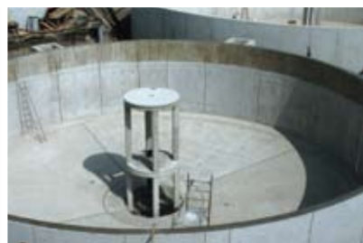
Швы резервуаров водоочистных сооружений
